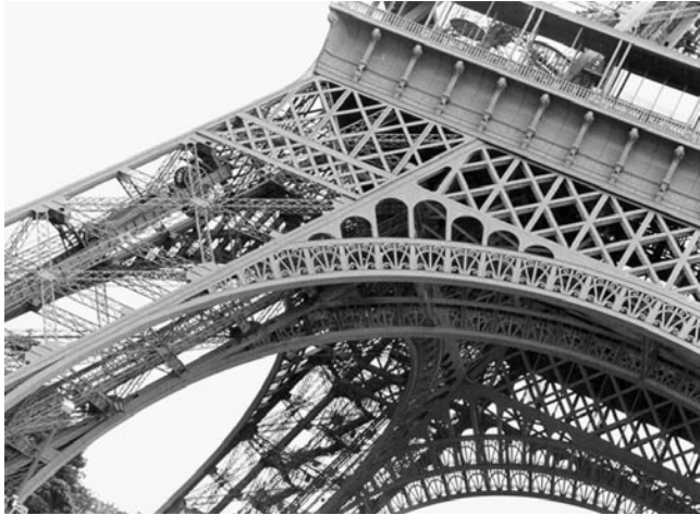
La delicada estructura reticulada de la torre Eiffel ilustra el descubrimiento que LaRouche hizo de joven en el astillero Charlestown de Boston: que la geometría euclidiana no se aplica al universo físico. En los 1980 se reconstruyó la torre para aligerar algunas de las partes superiores de su estructura. (Foto: Sami Huhtala).
