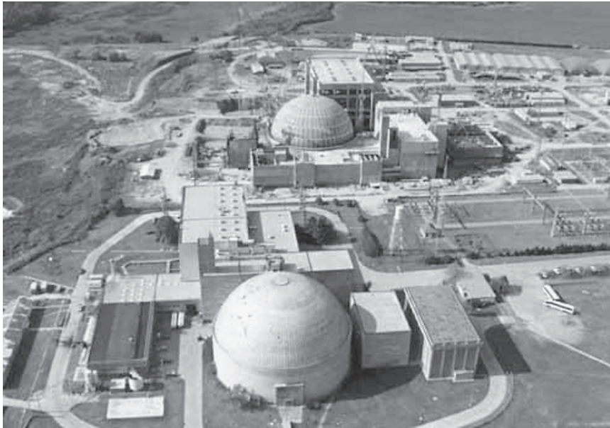
Para México, como para el mundo entero, una recuperación económica implica la construcción de obras de infraestructura de largo plazo en sistemas energéticos, hidráulicos, de transporte y sociales, tales como escuelas y hospitales. Planta nuclear Atucha en Argentina. (Foto: CNEA).
