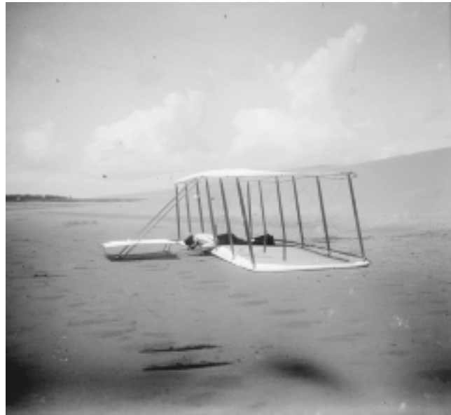
Wilbur Wright a los controles del planeador de los hermanos Wright de 1902, dotado de un timón de dirección, durante un vuelo en las colinas de Kill Devil en octubre de 1902. La conexión del timón de dirección al control de alabeo de alas fue el logro que les permitió a los Wright controlar el aparato en vuelo. (Foto: Wright State University Repository).
