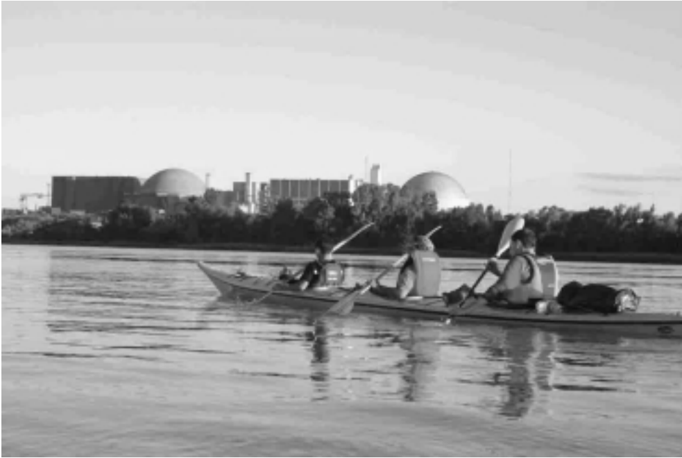
Argentina finalizará la construcción de la central nuclear ATUCHA II, ubicada al lado de Atucha I. (Foto: sitio electrónico de Delta en Kayak).
